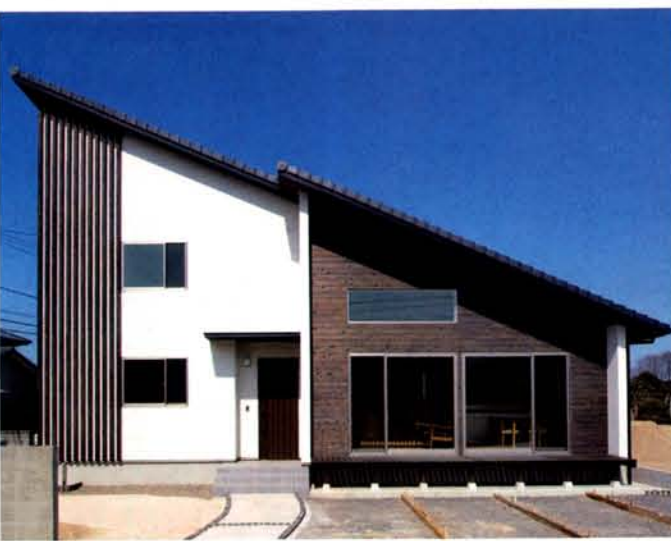
青い空に向かって真っすぐに伸びる大きな片流れの屋根。個性的なファサードは存在感抜群！ダイナミックな佇まいで、近隣のランドマークとなりそう
