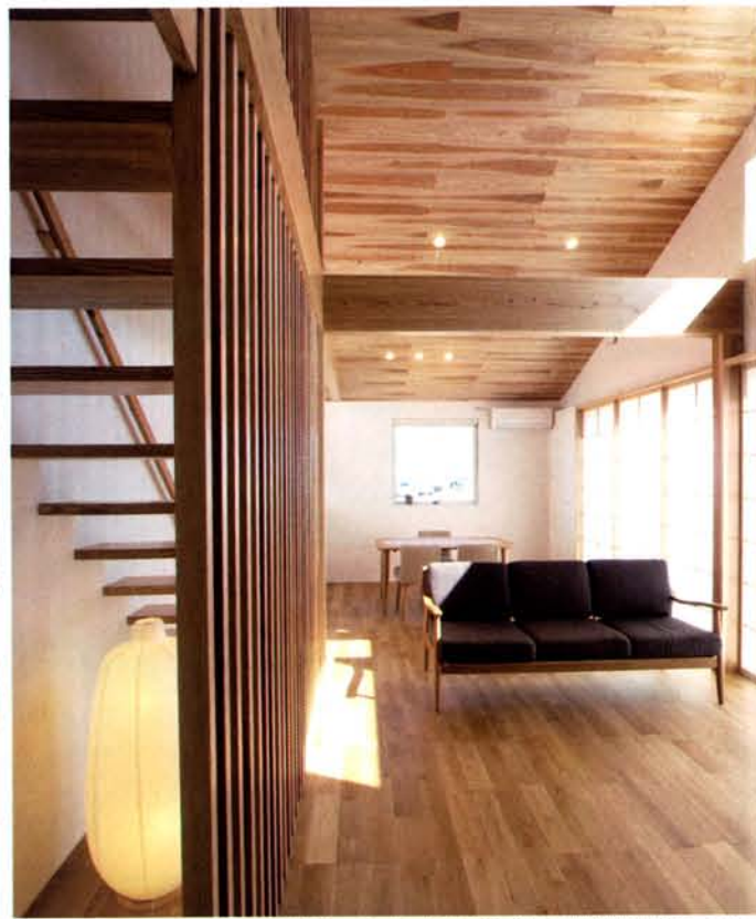
屋根の勾配から生まれた大空間。杉板貼りの勾配天井と大胆に残した構造材が空間にアクセントを与え、木の格子とストリップ階段という、難易度の高い設計で造作した印象的な空間
