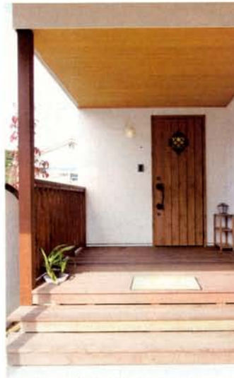
水に強いハードウッドを使ったデッキポーチ。耐久性が高いためメンテナンスもラクラク
