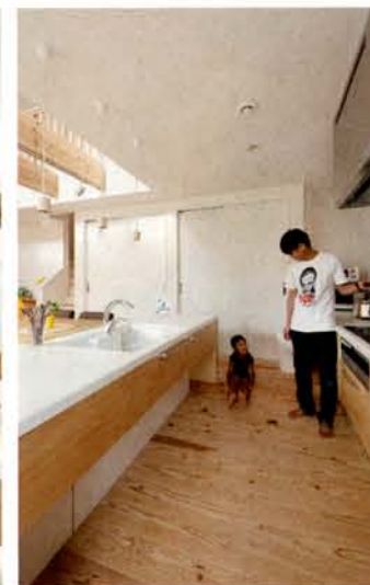
テーブルにいる家族と同じ高さの目線になるよう、キッチンの床をLDから1段下げて設計
