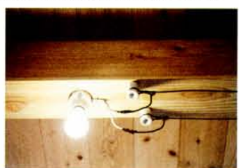
電線が表に出ている昔懐かしい硝子（がいし）引きの配線は、専門業者へ勉強にいき施工
