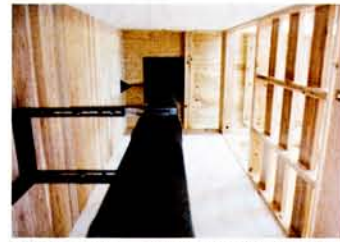
吹抜けで薪ストーブの暖かさを2階に届ける。暖気はシーリングファンで各部屋にも
