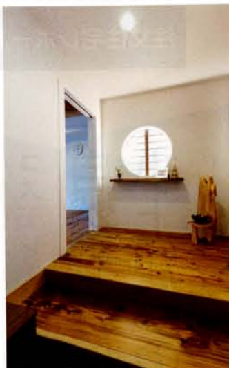
壁にライトを組み込んだ丸窓。障子が明るく照らされる玄関のアクセントウォール
